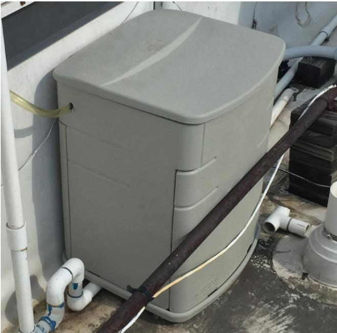
Le boîtier pour l'installation de l'équipement à l'extérieur protège l'appareil Fragrance Central des intempéries. Utiliser ce boîtier à tout endroit où une installation à l'extérieur est requise.
